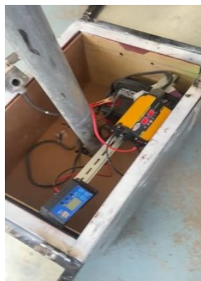
Figura 10. Compuertas de protección
